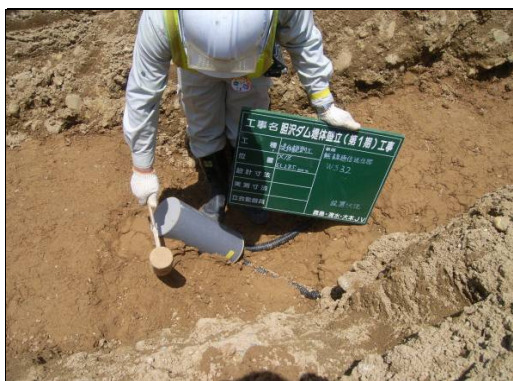
③設置状況(送信器周辺の突き固め)
