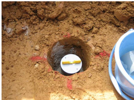
③設置状況(設置地盤のコア抜き)
