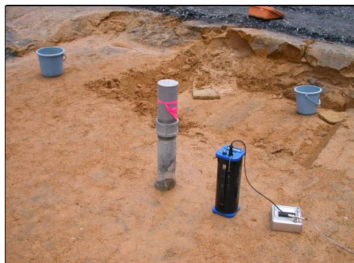
⑦設置例-3 御前山ダム(孔内型)
