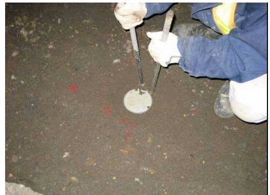
④設置状況(筐体周囲の突き固め)
