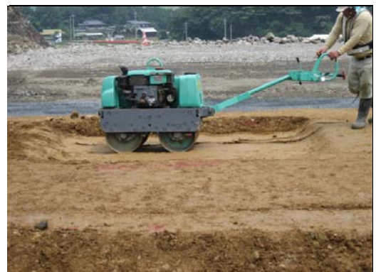
⑧埋戻し、転圧状況
