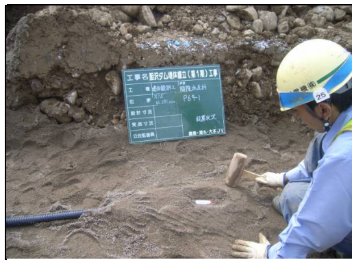
②設置状況(計器周辺の突き固め)
