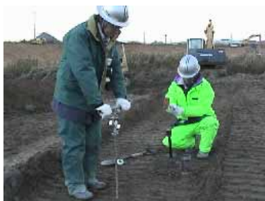
コーン貫入試験と供試体採取状況
