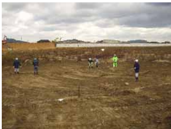
写真 5.4 現場試験ヤードの整地・計測状況
