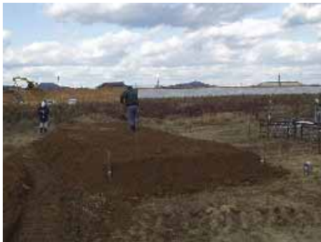
堤体土の撒き出し
