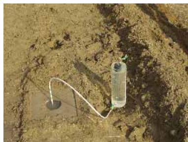
透水試験状況
