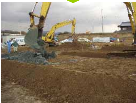
底泥土の撒き出し
