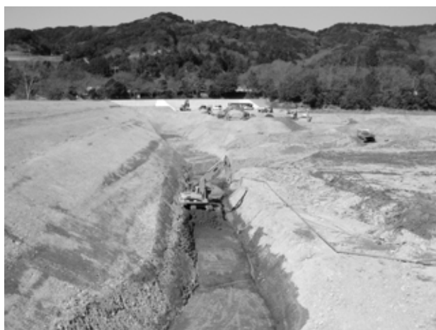
既設堤体と止水トレンチ掘削
