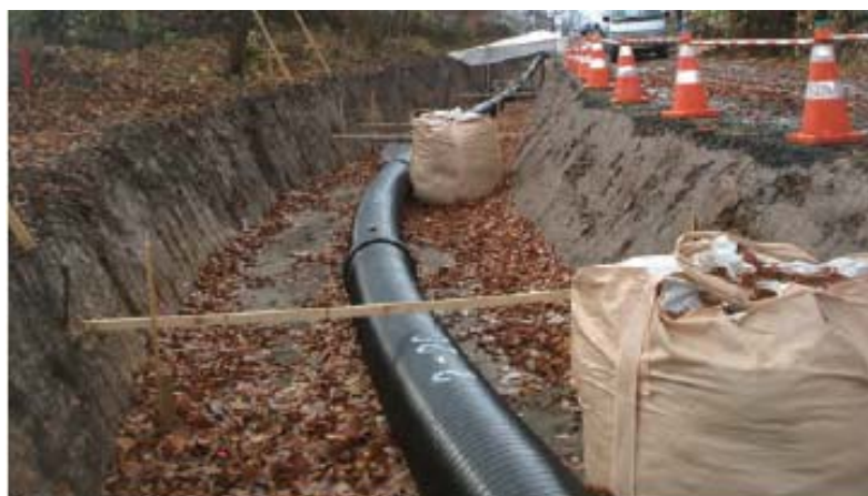
写真 2-3-1 現地曲げ配管状況(管の柔軟性)
