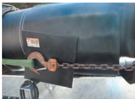
写真 4-3 レバーブロック干渉部の保護
