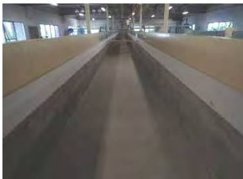
図-29 選定工法施工後の実験水路内面
