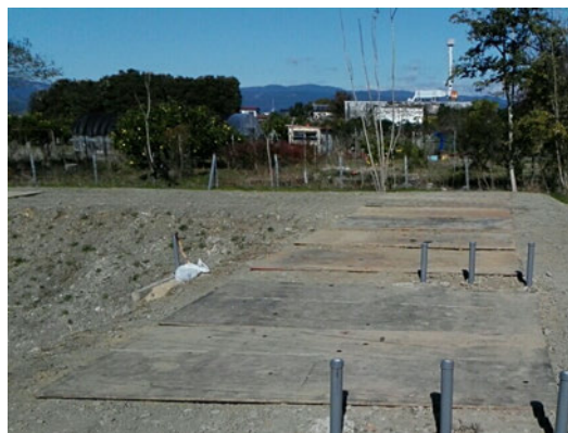
観測井設置（有孔パイプ建込）完了
