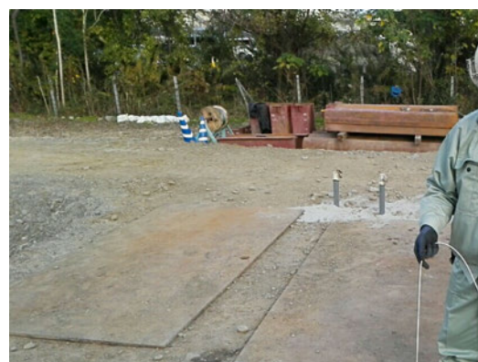
水位計による水位計測状況
