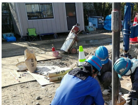
観測井設置（有孔パイプ建込）状況
