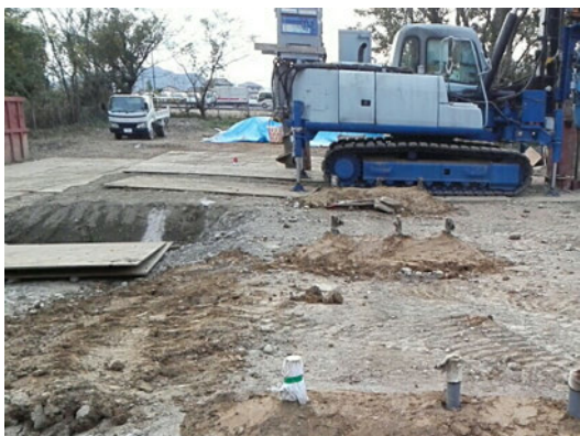
観測井設置（覆土）完了
