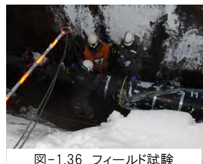
図-1.36 フィールド試験 (EF 継手施工)
