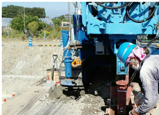
函体内土砂撤去、掘削高さ確認状況
