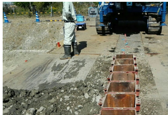
函体打設完了
