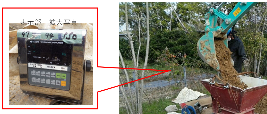
写真-13 電子秤によるベントナイト混合土計量状況
