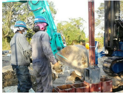
特殊油圧バケットによる函体内土砂撤去状況
