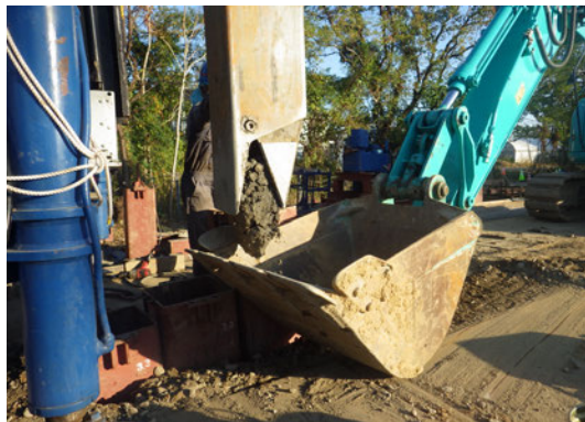
函体内土砂撤去状況
