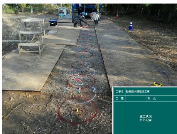
先行削孔 杭芯設置
