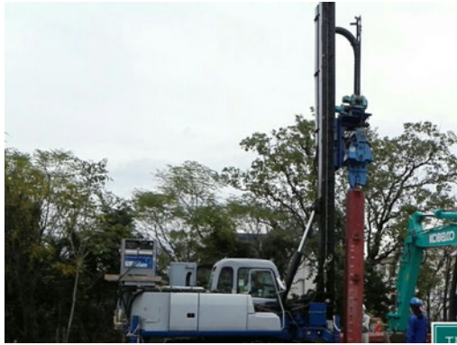
函体打設状況
