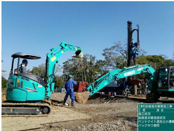
計量済みベントナイト混合土小運搬
