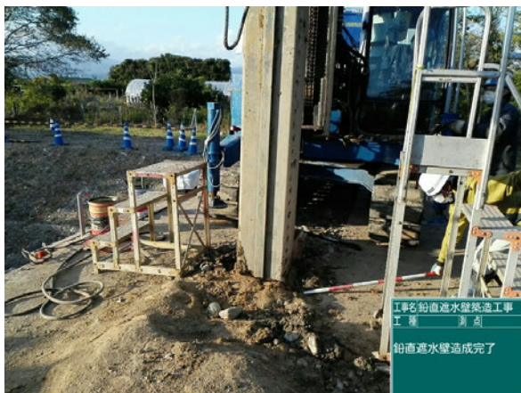
ベントナイト混合土鉛直遮水壁 造成完了
