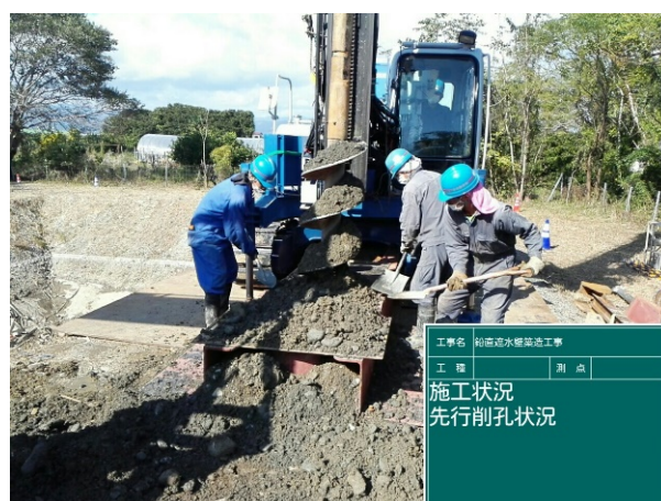
先行削孔 施工状況 ( \phi 550 \text{ mm} , L=3.3 \text{ m} )
