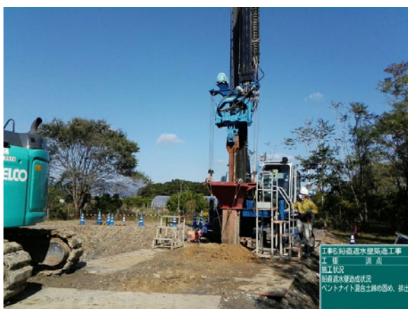
ベントナイト混合土排出・締め
