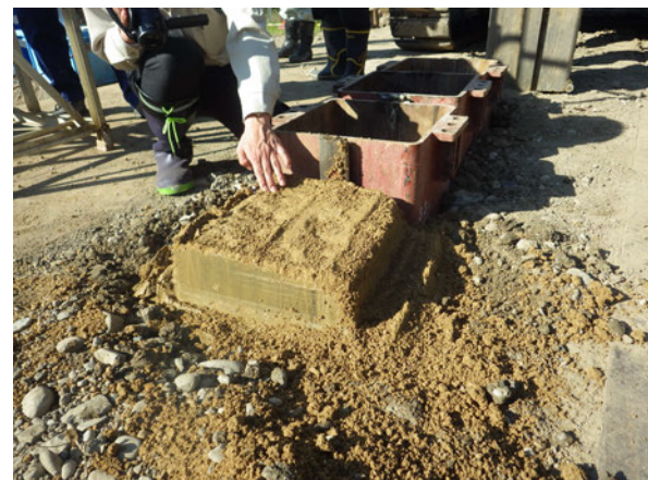
ベントナイト混合土鉛直遮水壁 造成完了杭頭部確認
