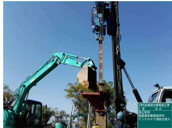
函体へのベントナイト混合土投入
