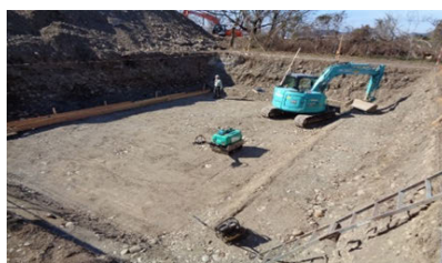
床付け完了状況
