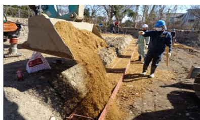
型枠設置、混合土投入
