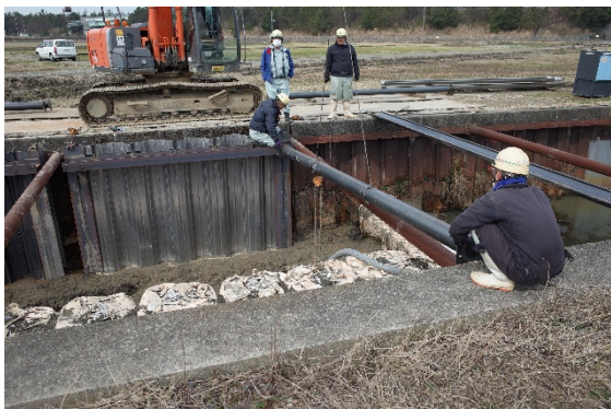
図 1.7.32 切梁施工
