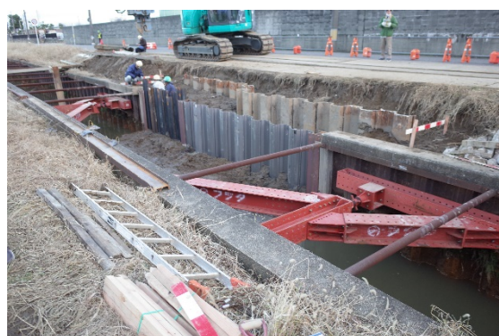
図 1.7.17 ステンレス鋼矢板施工完了
