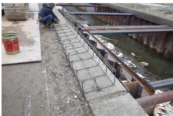
図 1.7.34 笠コンクリート用鉄筋組立
