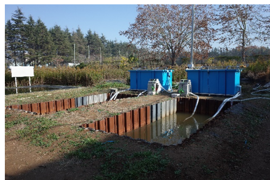
図 1.2.10 大型水槽設置
