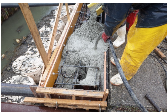
図 1.7.36 笠コンクリート打設
