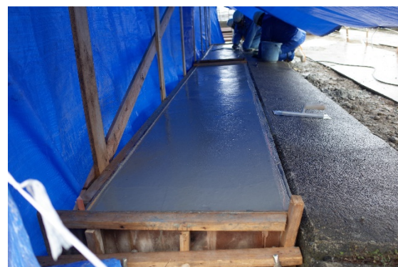
図 1.7.37 笠コンクリート養生工
