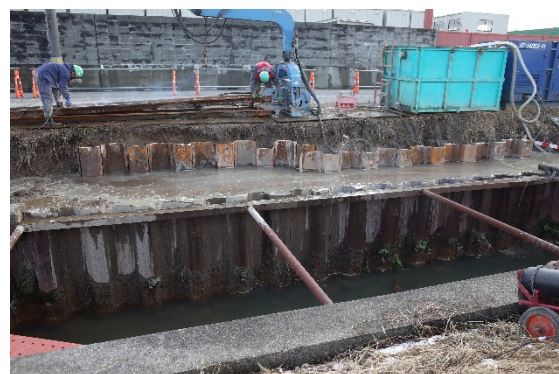
図 1.7.13 仮設土留め施工完了
