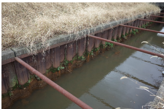
図 1.7.10 既設鋼矢板護岸の状況
