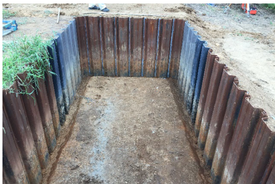
図 1.7.4 底面の掘削
