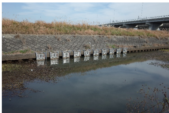
図 1.2.27 架台設置状況
