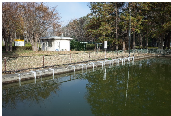
図 1.2.29 架台設置状況
