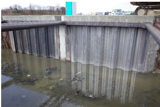
図 1.7.38 施工完了①
