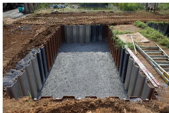
図 1.7.7 地盤改良 STEP 3
