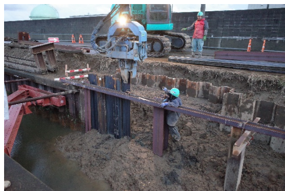
図 1.7.15 新設鋼矢板施工（普通鋼）
