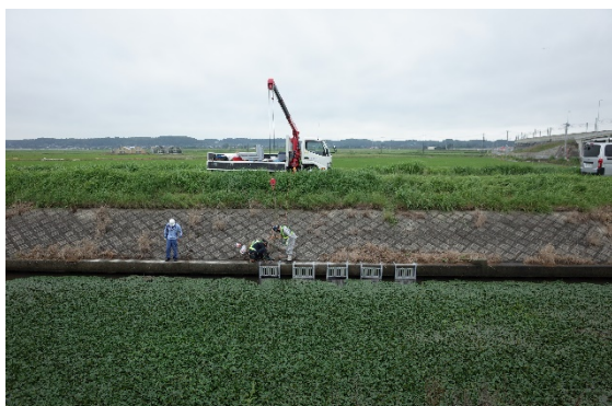
図 1.2.26 架台施工状況
