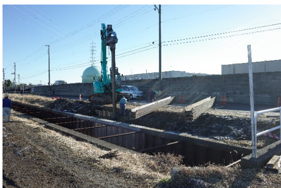
図 1.7.22 仮設土留めの引き抜き
