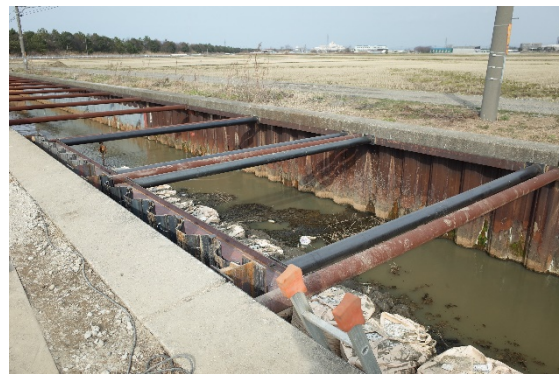
図 1.7.33 腹起し・切梁施工完了
