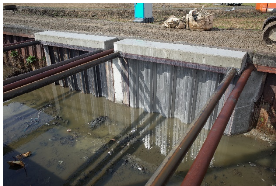
図 1.7.39 施工完了②
