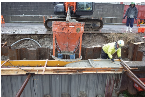
図 1.7.20 笠コンクリート打設
