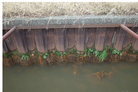
図 1.7.11 既設鋼矢板護岸の状況（拡大）
