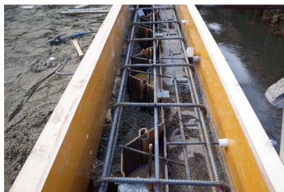
図 1.7.19 笠コンクリートの配筋施工
