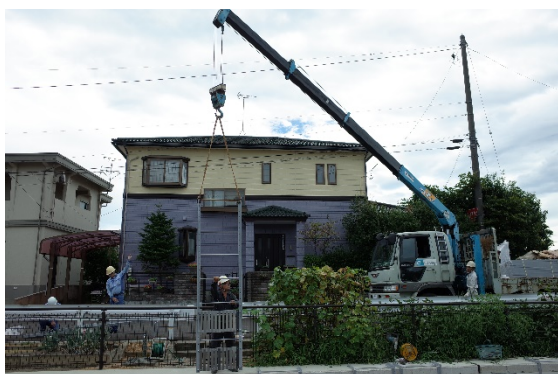
図 1.2.32 架台施工状況
