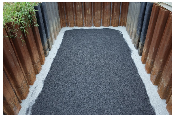
図 1.7.5 地盤改良 STEP 1
