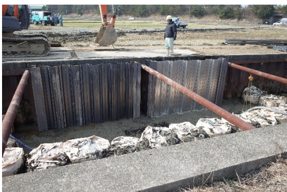
図 1.7.30 新設鋼矢板の打設完了
