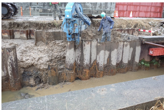
図 1.7.14 既設鋼矢板の引き抜き
