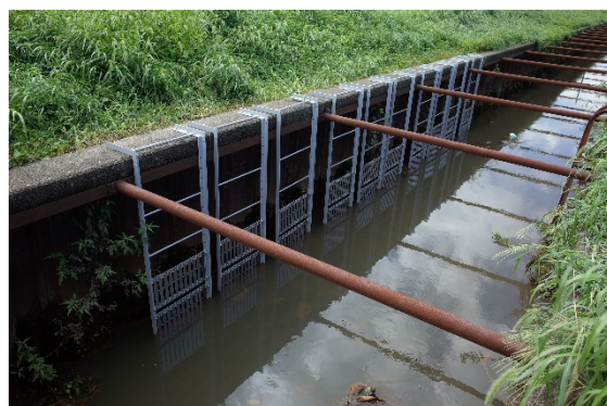
図 1.2.35 架台設置状況
