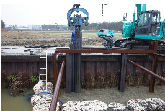
図 1.7.28 新設鋼矢板の打設（普通鋼）
