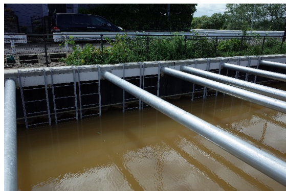
図 1.2.33 架台設置状況
