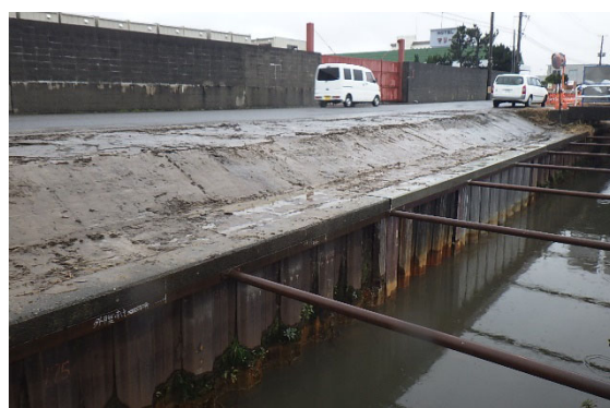
図 1.7.23 背面盛土の整地
