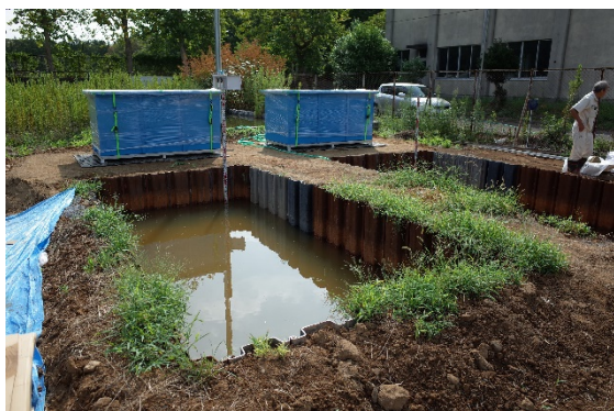
図 1.7.8 大型水槽設置
