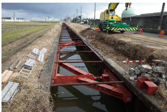
図 1.7.12 支保工設置状況
