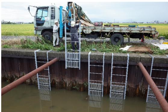
図 1.2.30 架台施工状況
