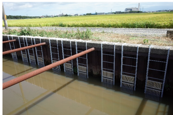
図 1.2.31 架台設置状況
