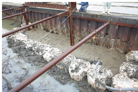
図 1.7.27 既設護岸の状況（仮締切）
