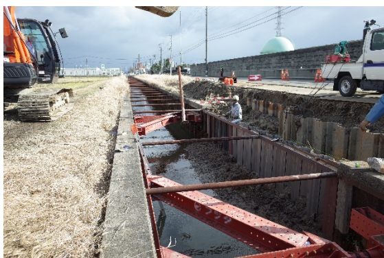
図 1.7.18 腹起し・切梁の施工
