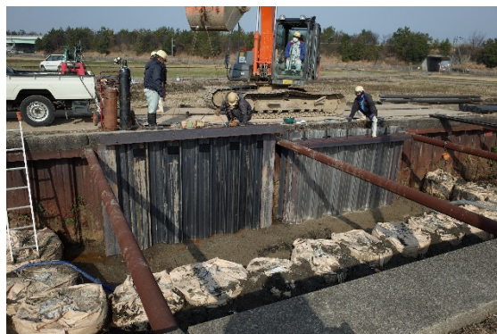
図 1.7.31 腹起し施工
