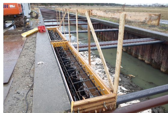
図 1.7.35 型枠施工
