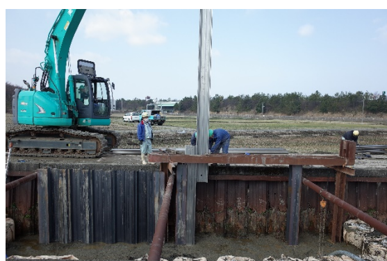
図 1.7.29 ステンレス鋼施工
