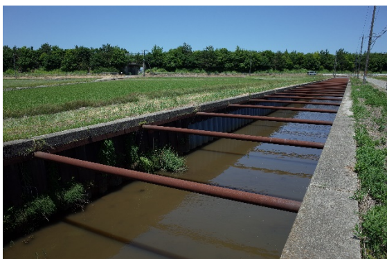
図 1.7.26 既設鋼矢板護岸の状況
