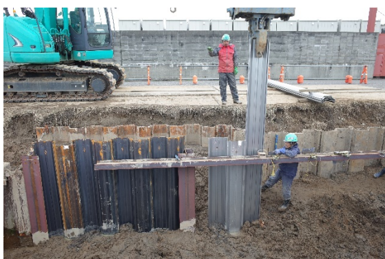
図 1.7.16 ステンレス鋼矢板施工
