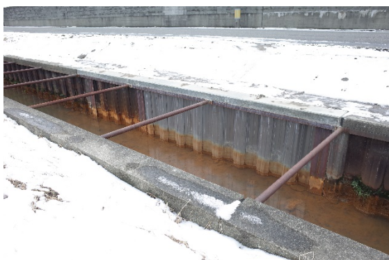
図 1.7.24 完成（施工後 2 週間）①
