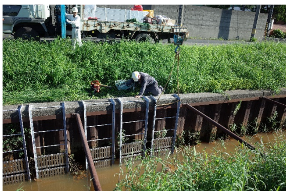
図 1.2.34 架台施工状況
