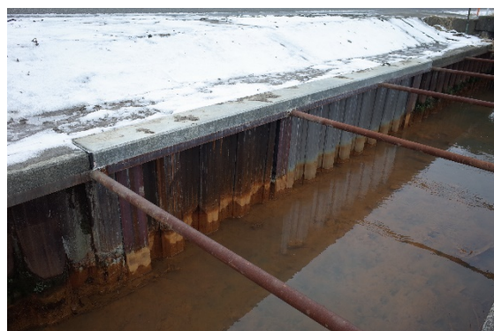
図 1.7.25 完成（施工後 2 週間）②
