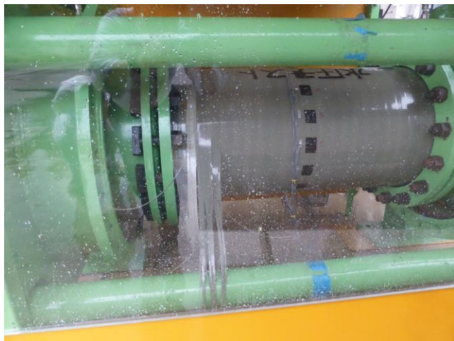
図 3.3.6 呼び径 450FRPM 管(内圧 3 種)漏水状況
