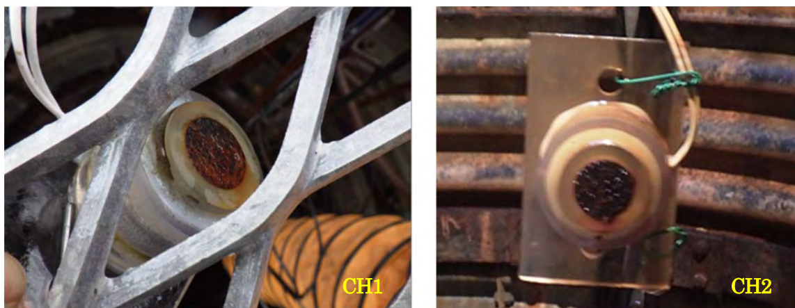
図 1-6-1-2 平成 29 年 12 月時点での腐食センサーの状況（設置から約 1 年半後）
