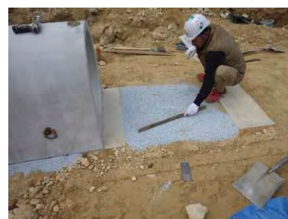
図-4.4.5(5) ベントナイト敷設
