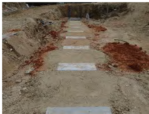
図-4. 4. 4(2) 基礎地盤の締め固め完了
