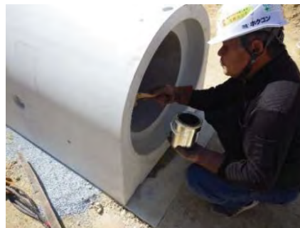
図-4.4.5(3) 凹側受け口への滑材塗布
