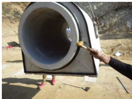
図-4.4.5(2) 耐震ゴムリングへの滑材塗布
