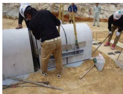
図-4.4.5(7) 拘束部製品の吊り
