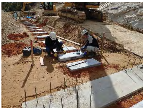
図-4. 4. 4(1) プレキャスト基礎板の据付
