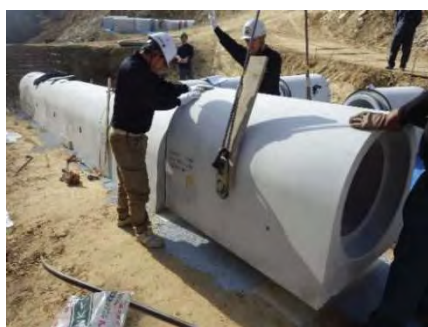
図-4.4.5(6) 標準製品の吊り
