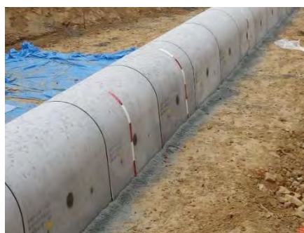
図-4.4.5(11) ベントナイト設置状況
