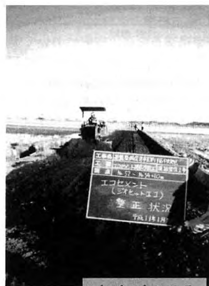
ブルドーザーによる 不陸修正
