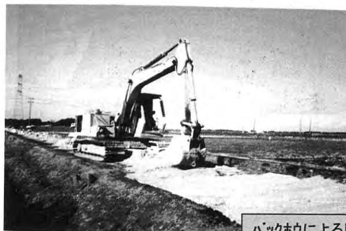
バックホウによる固化材 散布
