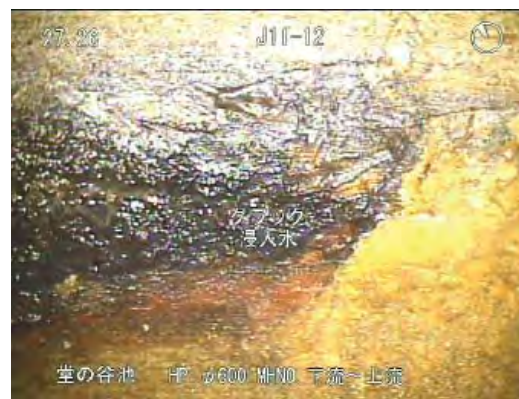
写真 4 漏水状況
