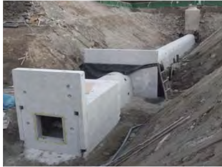
図 7 プレキャストコンクリート製ため池底樋の施工実例
