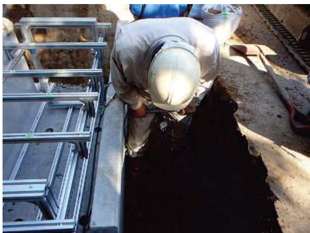
写真 2 8 ホータブルコン貫入試験状況
