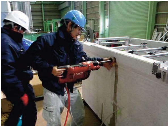
写真 8 小径コアによる削孔状況
