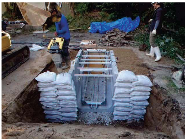
写真 2 6 基礎材転圧状況
