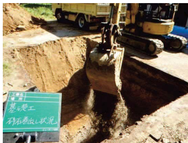
写真 2 1 砕石巻き出し状況
