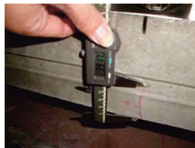
写真 6 ひび割れ状況
