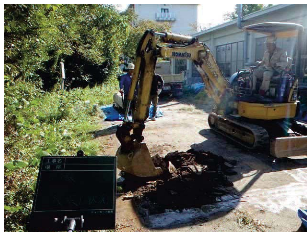
写真 1 9 舗装取り壊し状況
