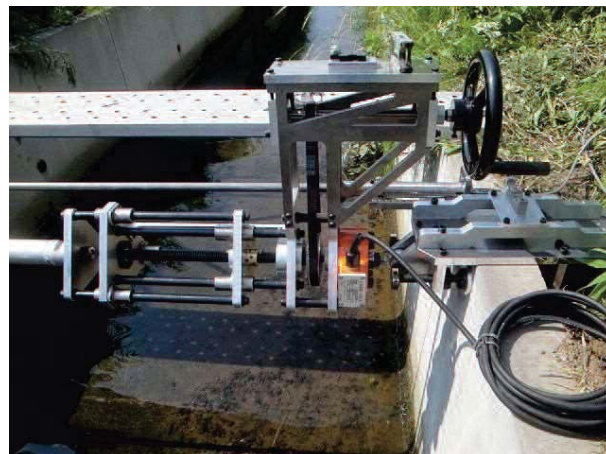
写真 1 3 水路壁載荷装置の設置状況
