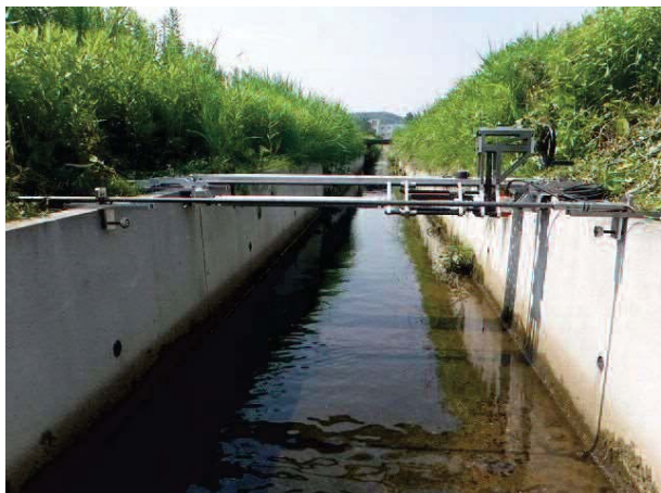
写真 1 2 水路壁載荷装置の設置状況
