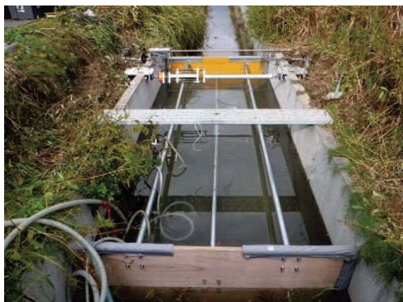
写真 1 4 滞留水の状況
