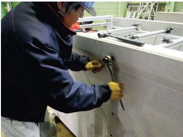
写真 10 ボルト締結状況
