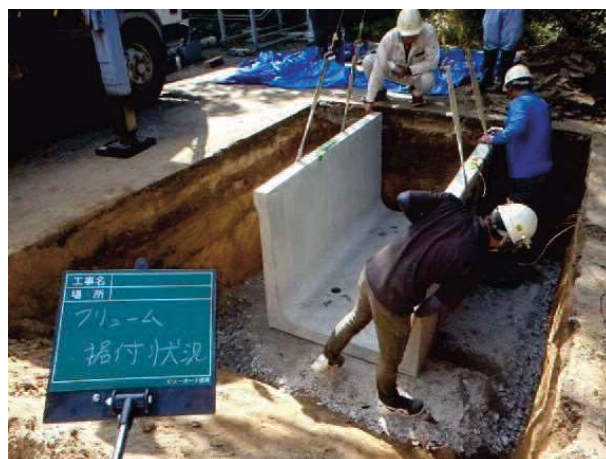
写真 2 3 試験体設置状況
