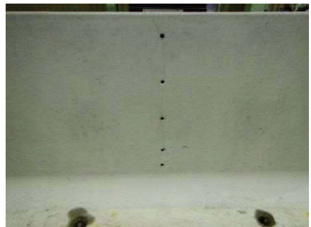
写真 11 ひび割れ発生状況
