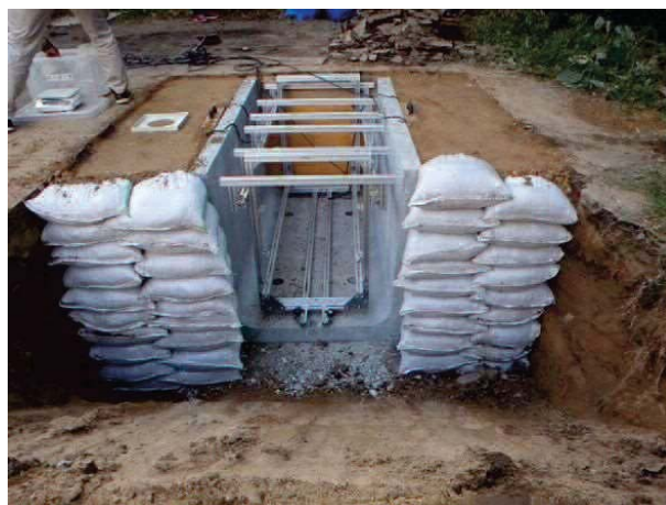
写真 2 7 施工完了状況
