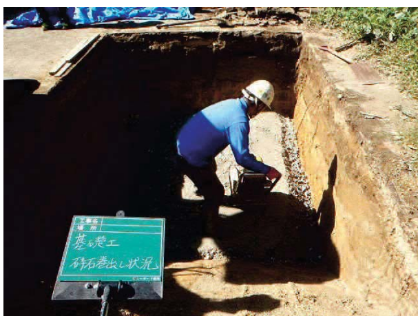
写真 2 2 砕石巻き出し状況
