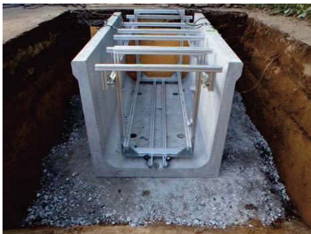
写真 2 4 試験体設置状況
