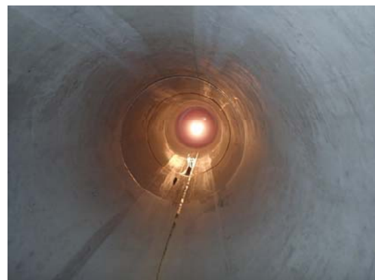
写真 37 管内調査状況
