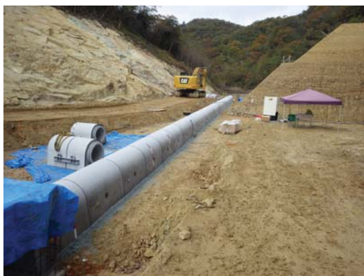
写真 35 PCa 底樋管施工完了状況
