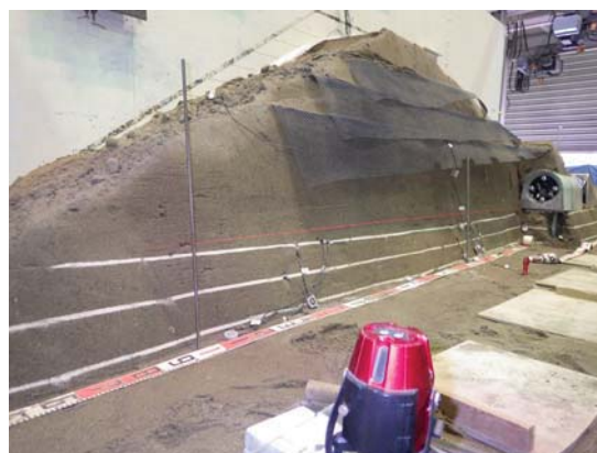
写真 30 ブロック撤去後
