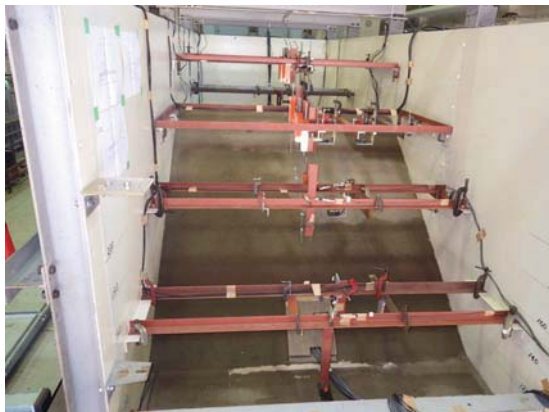
写真 27 堤体構築完了状況
