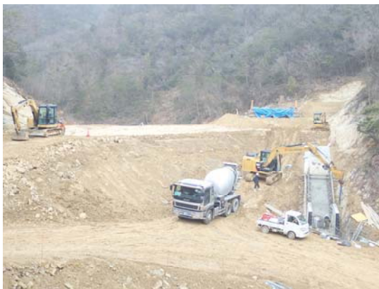
写真 36 堤体施工状況
