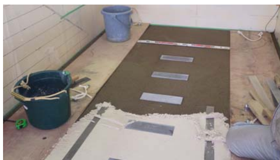
写真 25 基礎構築状況
