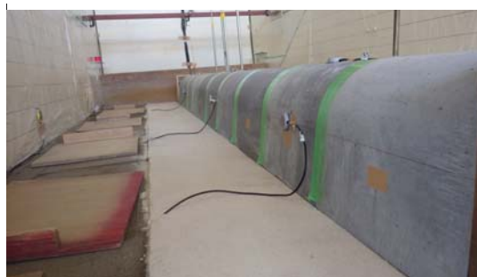
写真 26 ブロック敷設完了
