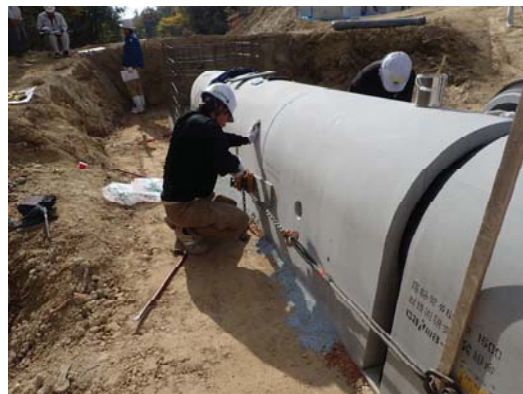
写真 34 PCa 底樋管引き寄せ状況
