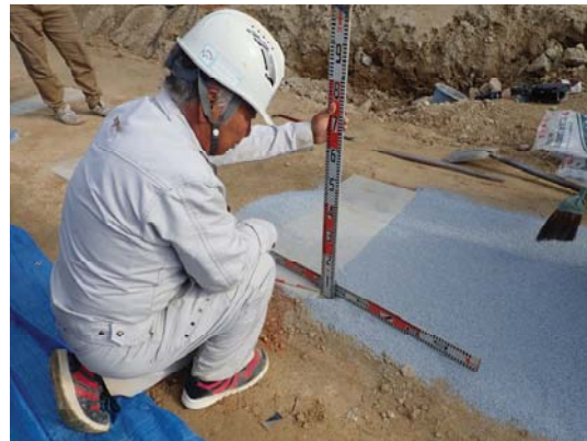
写真 32 ベントナイト厚計測状況
