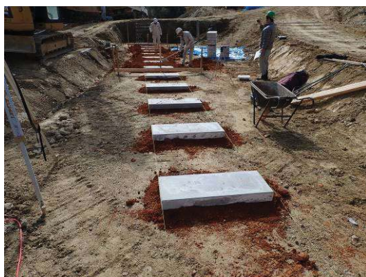
写真1 PCa 基礎パネル設置完了状況
