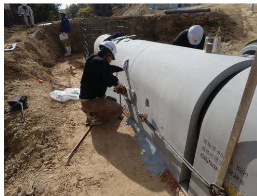
写真4 PCa 底樋管引き寄せ状況
