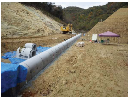
写真 5 PCa 底樋管施工完了状況
