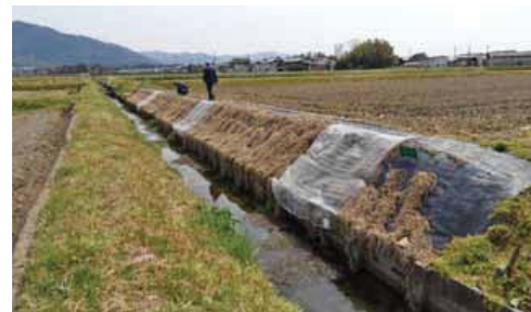
20190329 一部べた掛け資材設置
