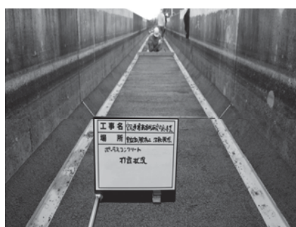
②底版部ポラコン打設
