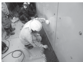
⑤側版設置
