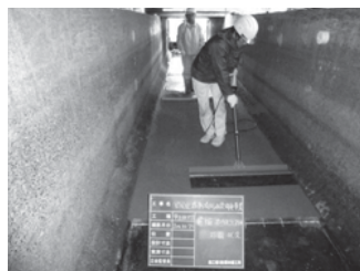
③底版打設
