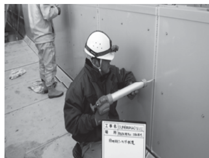
⑥目地材シーリング
