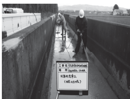
①水路内洗浄
