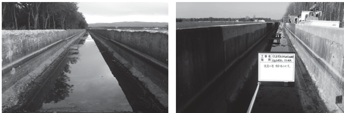
図(6)－8 既設コンクリート復旧状況(左：復旧前、右：復旧後)
