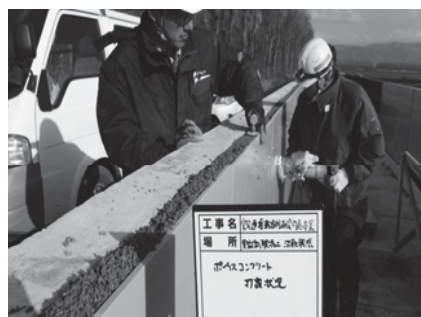
④側版ポラコン打設
