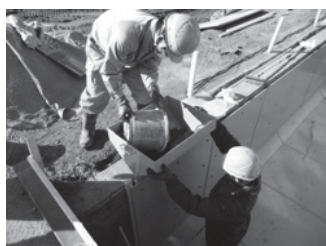
⑥側版打設
