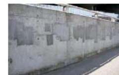
ひび割れ補修（断面修復工）
