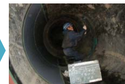
鋼管内面塗装
