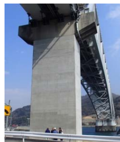
橋脚耐震補強 RC巻立
