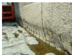
頭首工導流壁の鉄筋露出や土砂吐の洗掘
