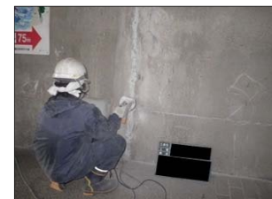
橋脚のひび割れ補修
