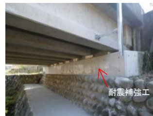
橋梁耐震補強工
