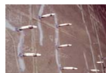
ひび割れ補修 （樹脂注入工法）
