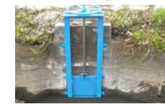
分水ゲート等の更新
