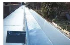
ひび割れ補修（表面被覆工）
