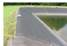
遮水シート補修
