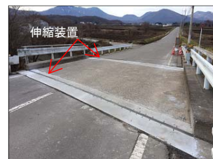
伸縮装置交換 （止水機能等の回復）
