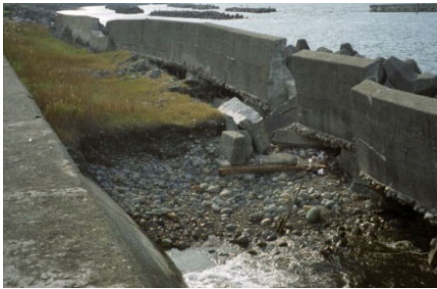
老朽化により倒壊した堤防の敷設替え
