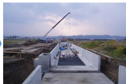
老朽化により倒壊した開水路の布設替え
