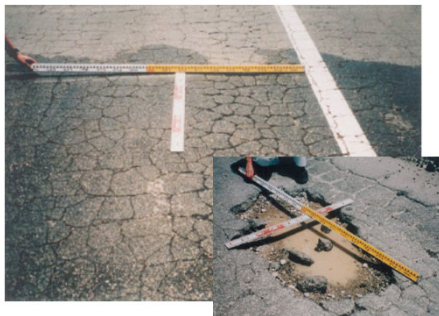
路面の亀裂・わだちが顕著となり表層から路床まで造り替え
