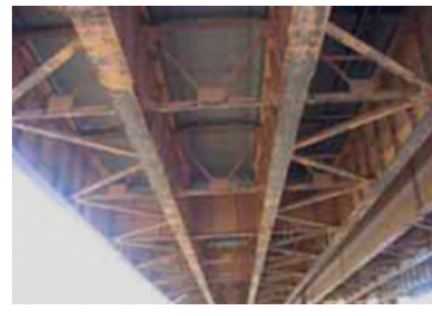
鋼材（桁材）の劣化進行が顕著となり再建設
