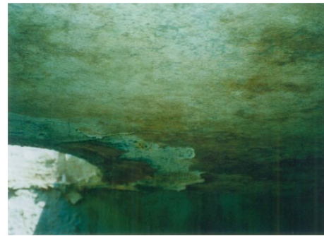
劣化したコンクリート防食の補修
