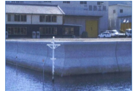
大きなひび割れに対し護岸を更新整備
