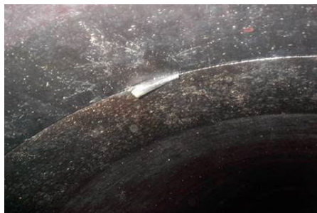
漏水する継目を内面バンドで補修
