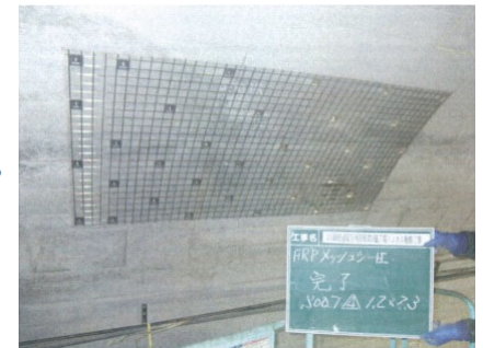
コンクリートの浮き・剥離箇所にFRPメッシュシートを貼り落下予防
