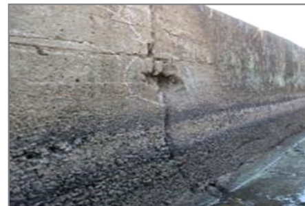
劣化した水路を表面被覆材で補修
