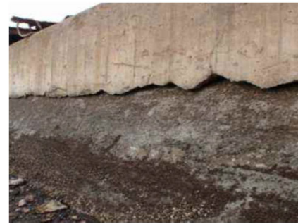
波浪による先掘からの堤体陥没を防ぐため、脆弱部を補修・補強
