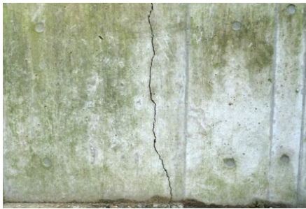
劣化した堤防表面ひび割れをモルタル注入により補修
