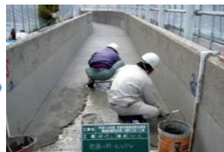
劣化した水路を表面被覆材で補修
