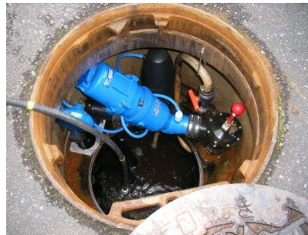
マンホール内真空弁の交換
