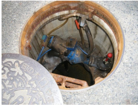
マンホール内真空弁の交換
