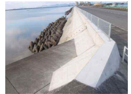
波浪による先掘からの堤体陥没を防ぐため、脆弱部を補修・補強
