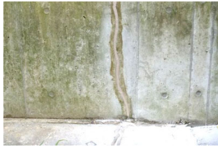
劣化した堤防表面ひび割れをモルタル注入により補修
