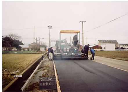
損傷した表層をアスファルト材により補強（オーバーレイ）
