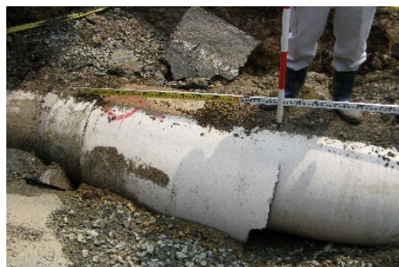
老朽化により破損した管水路の布設替え
