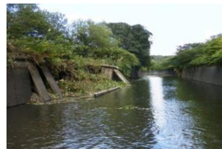
老朽化により倒壊した開水路の布設替え
