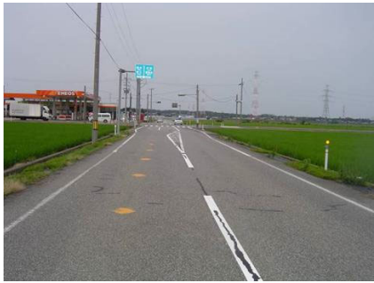
損傷した表層をアスファルト材により補強（オーバーレイ）
