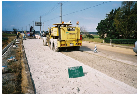
路面の亀裂・わだちが顕著となり表層から路床まで造り替え
