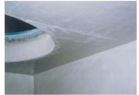
劣化したコンクリート防食の補修
