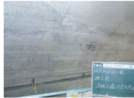
コンクリートの浮き・剥離箇所にFRPメッシュシートを貼り落下予防
