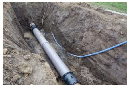
老朽化により破損した管水路の布設替え
