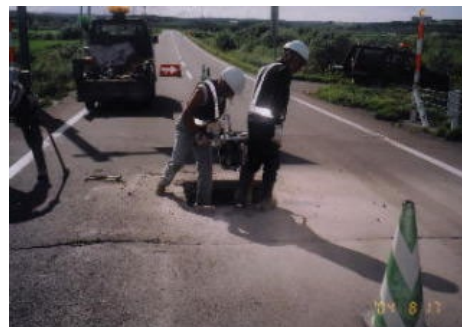
軽微な補修作業
