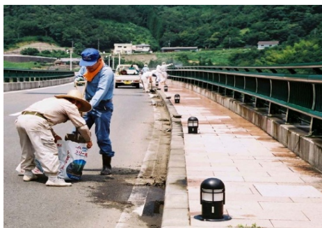
橋梁排水施設の清掃
