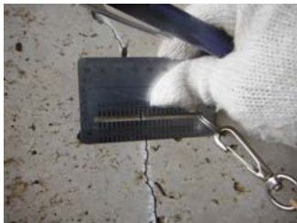
ひび割れ状況確認
