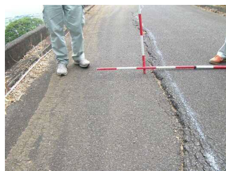
舗装点検の様子 (ひび割れ率、わだち掘れ量を測定)
