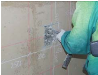
鉄筋腐食確認のためのコンクリートはつり
