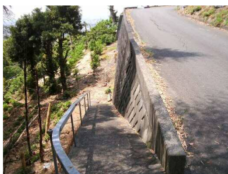
農道と法面の全景
