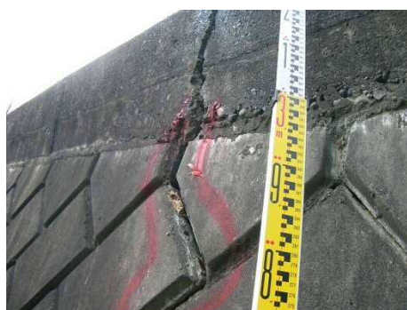
法面点検の様子 (クラック幅、延長等を測定)
