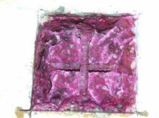
フェノールフタレイン溶液による中性化確認
