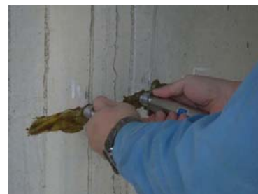
超音波ひび割れ深さ測定状況
