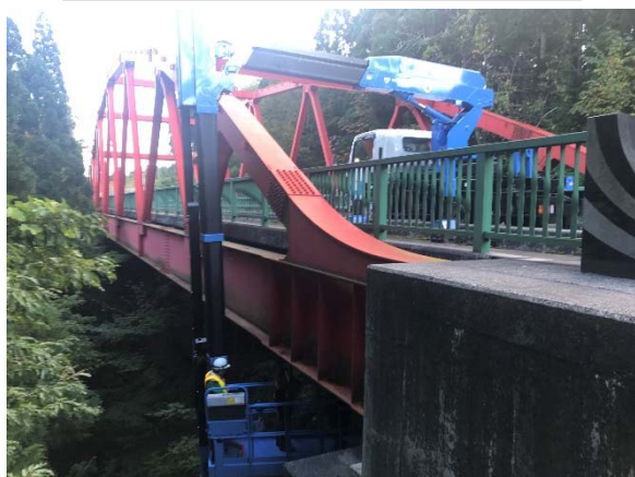
橋梁点検車使用状況
