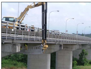
橋梁点検車による桁裏点検
