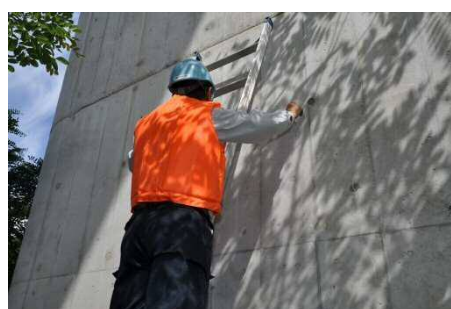
➤下部工上部は橋梁点検車により、下部は梯子等により検査。
