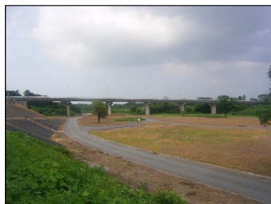
西神通橋全景
