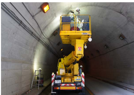
目視・打音調査
