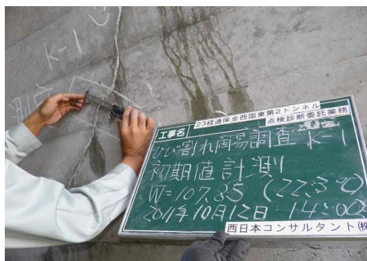
ひび割れ簡易調査
