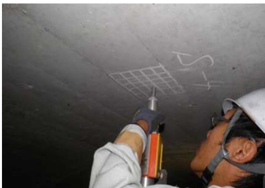
簡易覆工強度調査
