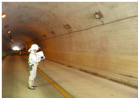
スケッチ・ひび割れ展開図作成
