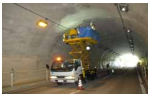
高所作業車による点検
