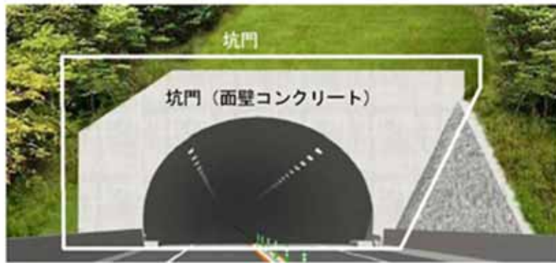
【図 - 5 (b) トンネルの定期点検対象箇所の例（トンネル坑口部） （道路トンネル定期点検要領（国土交通省道路局、H31.2））】
