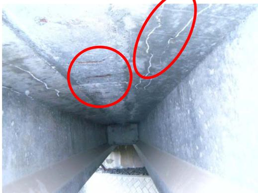
主桁上フランジ下面に0.2mm程度のひびわれ。間詰め部に鉄筋の露出。
