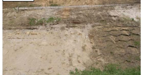
施工後:吹付け後約30日で植生が確認され、法面も安定している
