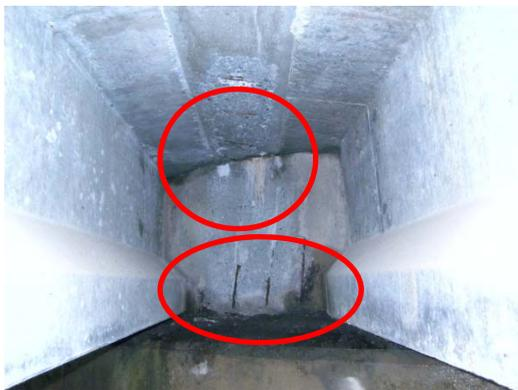
上方打ち継ぎ目から漏水痕、遊離石灰の析出及び鉄筋露出、発錆
