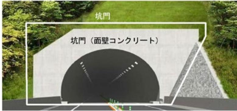
【図－5 (b) トンネルの定期点検対象箇所例 (トンネル坑口部)
