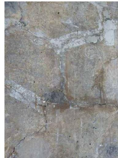
クラック注入を行っているが再び割れ幅が進行している。(ひび割れ幅1.0mm)
