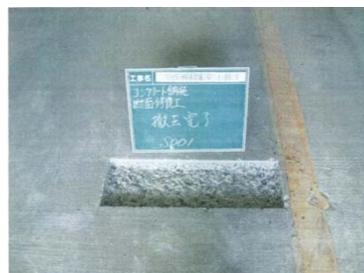
コンクリート切断～はつり撤去状況
