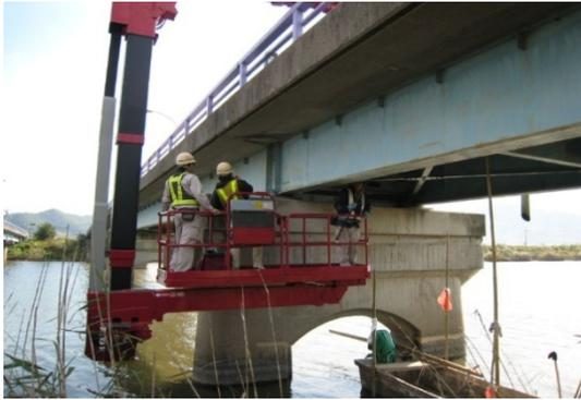
橋梁点検車両による点検
