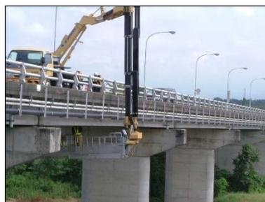
橋梁点検車による桁裏点検
