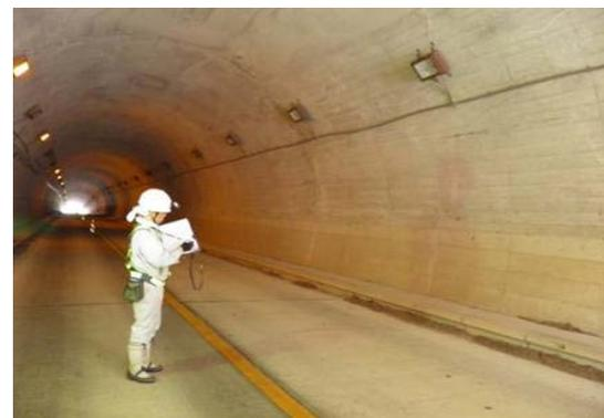
スケッチ・ひび割れ展開図作成
