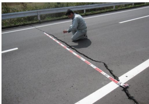
地震による舗装の亀裂
