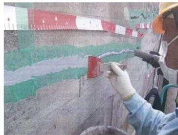
下地処理～充填材施工状況
