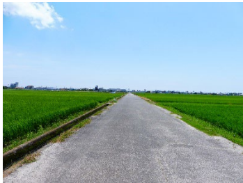
拡幅した農道
