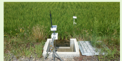
自動給水栓による水管理の軽減
