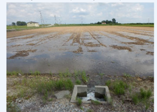
パイプラインから給水
