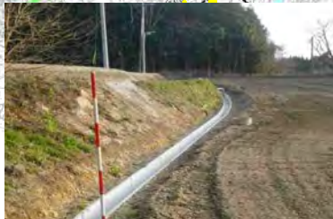
農地保全（排水路）
