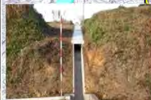
農地保全（排水路）
