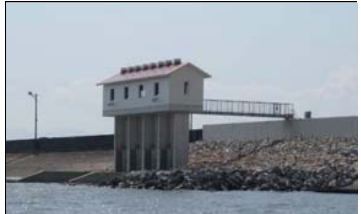
排水樋門工(完成後)
