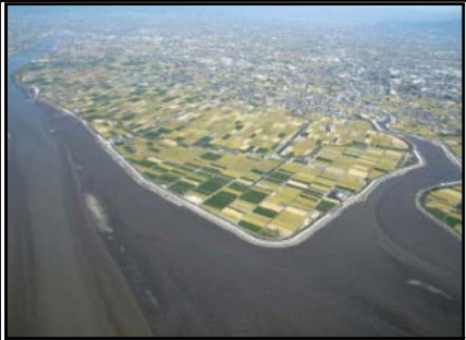
大和工区全景
