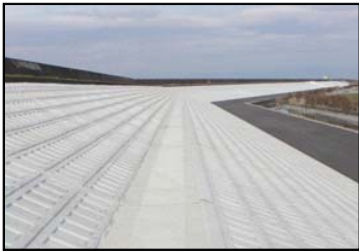
堤防舗装工 (完成後)
