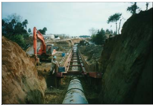
用水路施工状況
