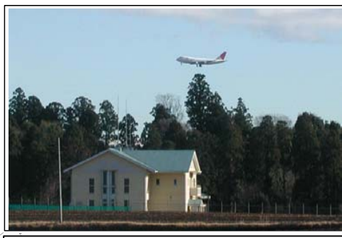
富里揚水機場
