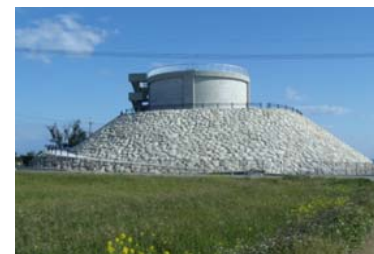
2号ファームポンド
