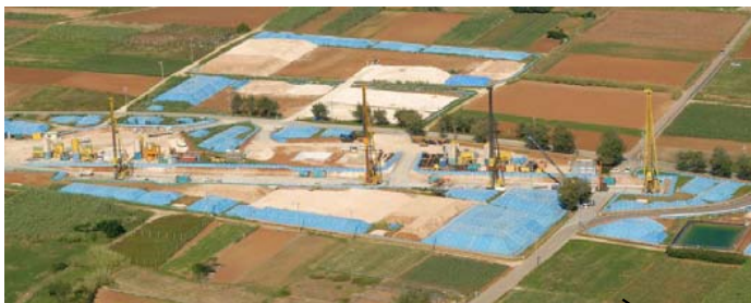
地下ダム施工状況
