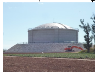
1号ファームポンド
