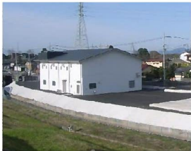
佐賀西部高域揚水機場
