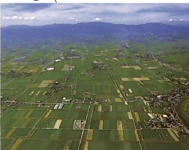
ほ場整備施工後
