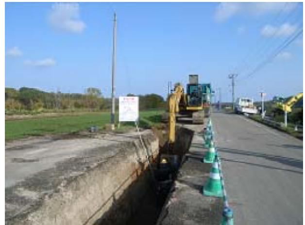
営農用水管路施工状況（平成20年撮影）
