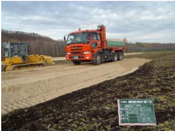
客土工施工状況（平成20年撮影）
