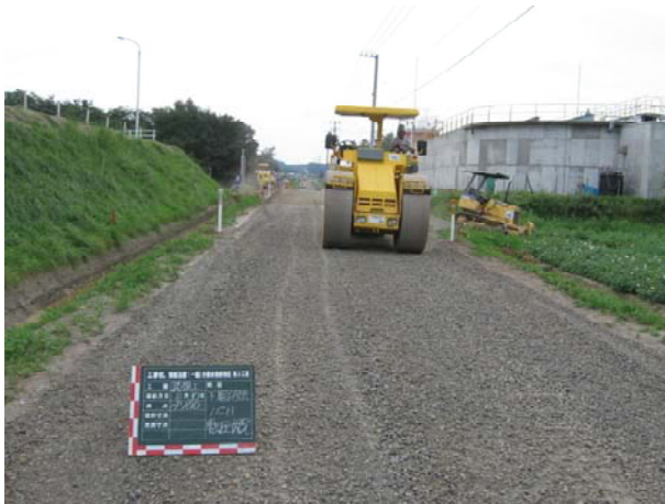
農道工施工状況（平成19年撮影）
