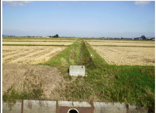
事業実施後（用排水路）（平成27年撮影）
