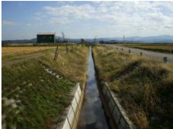
排水路整備状況（平成27年撮影）
