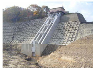
小田川ダム取水設備(改修後)
