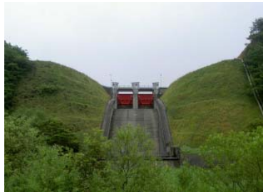
小田川ダム洪水吐周辺法面保護工(改修後)
