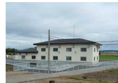
尻無揚水機場(改修後)
