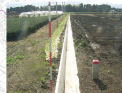
農地保全（排水路）
