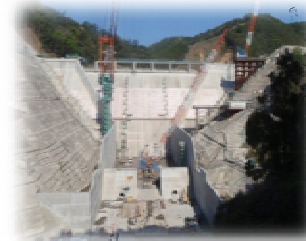
施工中の浜ノ瀬ダム
