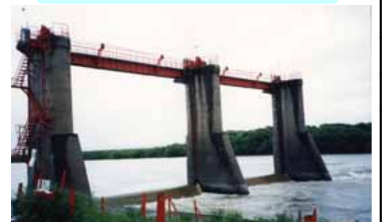
(旧)石狩川頭首工
