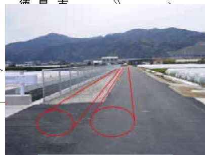
幹線導水路(施工後)
