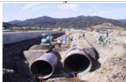
幹線導水路(施工中)
