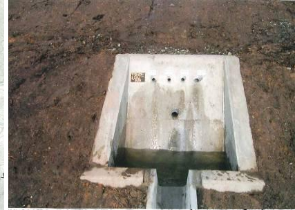
水抜きボーリング工
