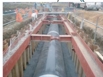
用水路施工状況
