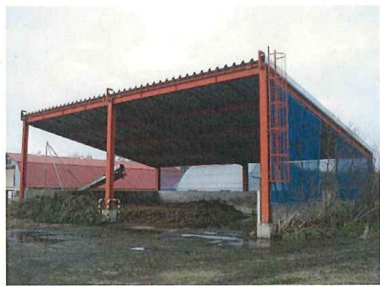
写真④ 堆肥舎
