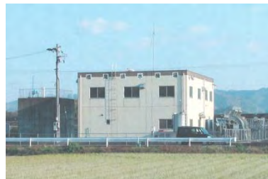
橋尾排水機場
