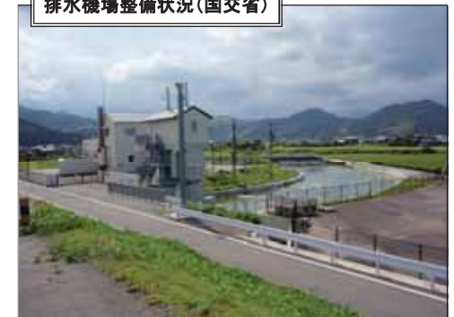
排水機場整備状況(国交省)
