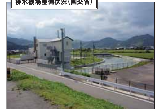
排水機場整備状況(国交省)
